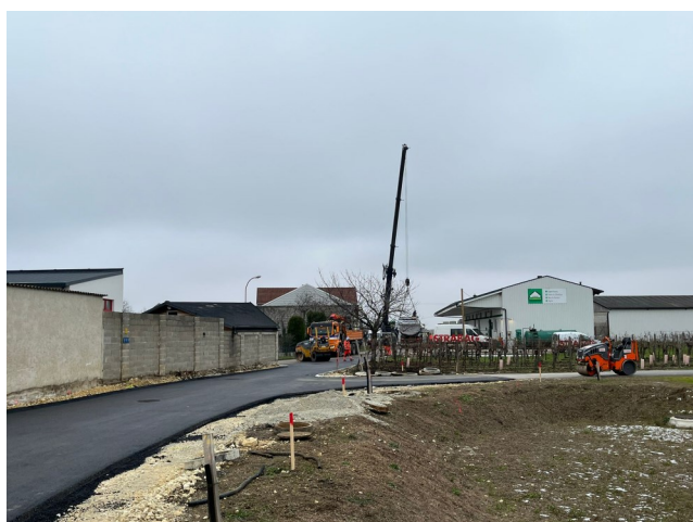
Asphaltierung - Raiffeisenstraße Richtung Lagerhaus
