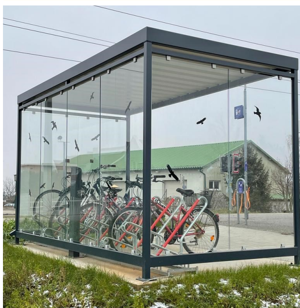
Überdachter Radabstellplatz mit E-Bike-Ladestation am Bahnhof
