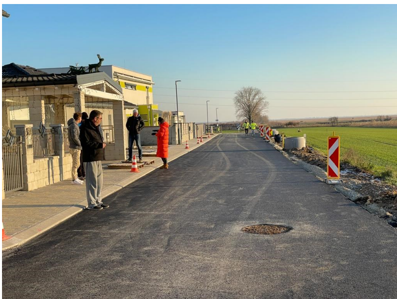
Asphaltierungsarbeiten der Fa. PORR „Am Satzer“
