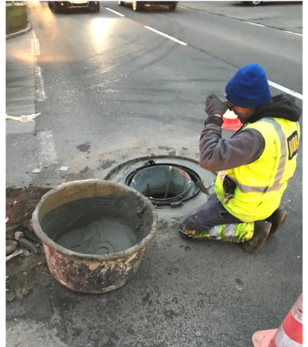
Sanierung eines Schachtdeckels an der B50
