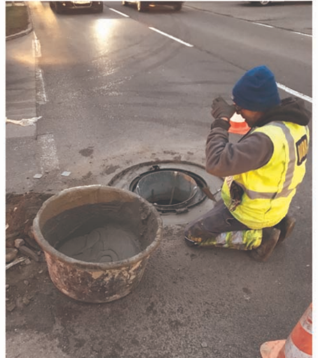
Sanierung eines Schachtdeckels an der B50
